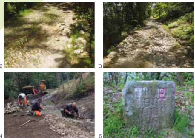
1 Mappa ottocentesca – Archivio del Comune di Gamberoglio 2/3 La strada prima del restauro – foto A. Pirrami 4 Operai al lavoro durante il restauro del 2015 – foto N. Käsermann 5 Antico cippo di confine, che tuttora delimita i Comuni di Monteceneri e Gamberoglio – foto A. Pirrami
